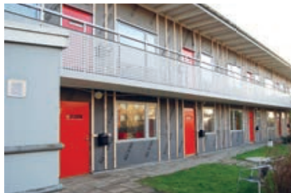
Inför julen pågår montage av fasadskivor och fönster, omfogning av tegelfasader samt nedmontering av ställningar.
